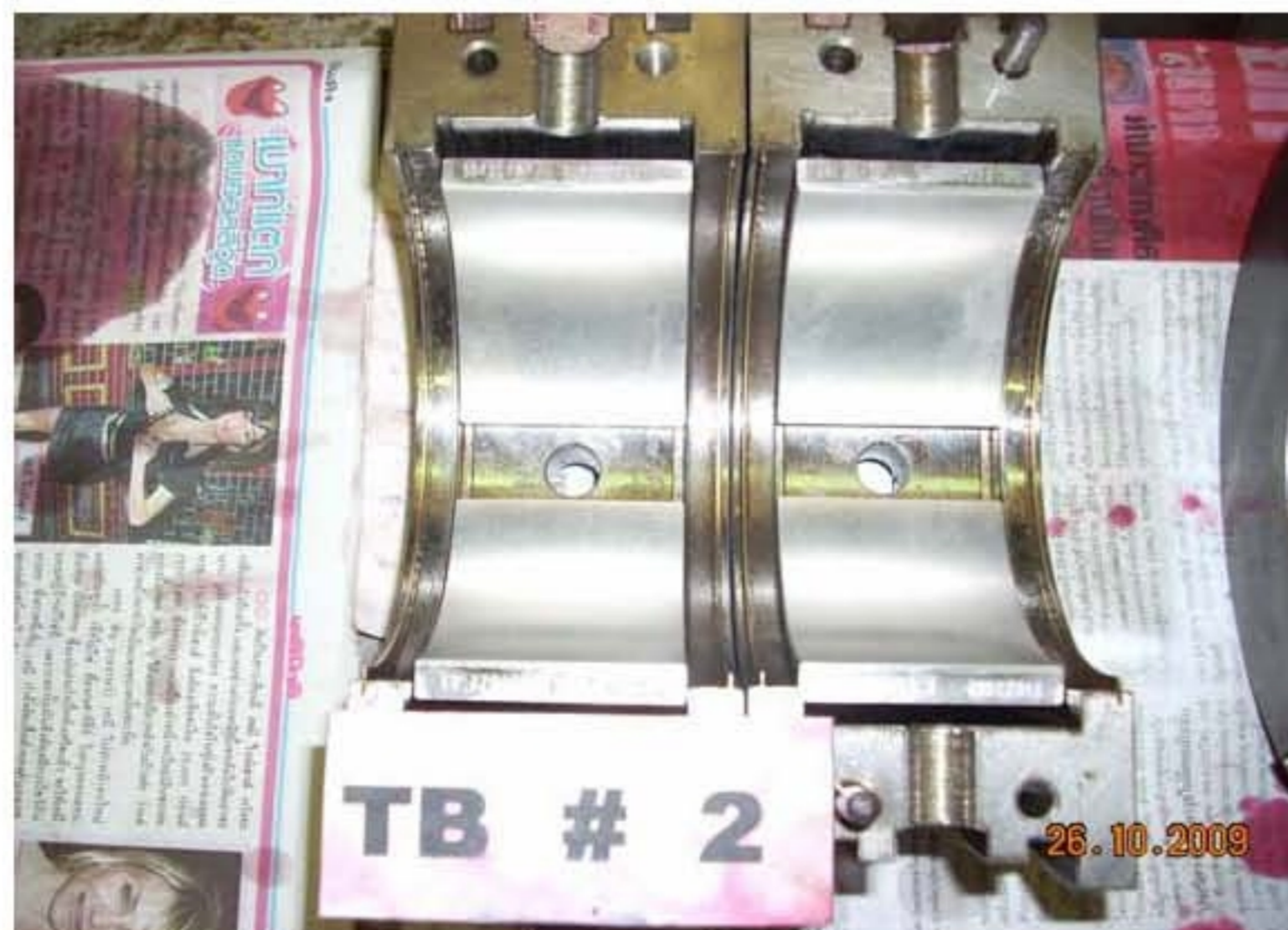
ภาพแสดง สภาพของ JOURNAL BEARING ของ STEAM TURBINE ด้าน EXHAUST END ที่ทำการเปลี่ยนใหม่
