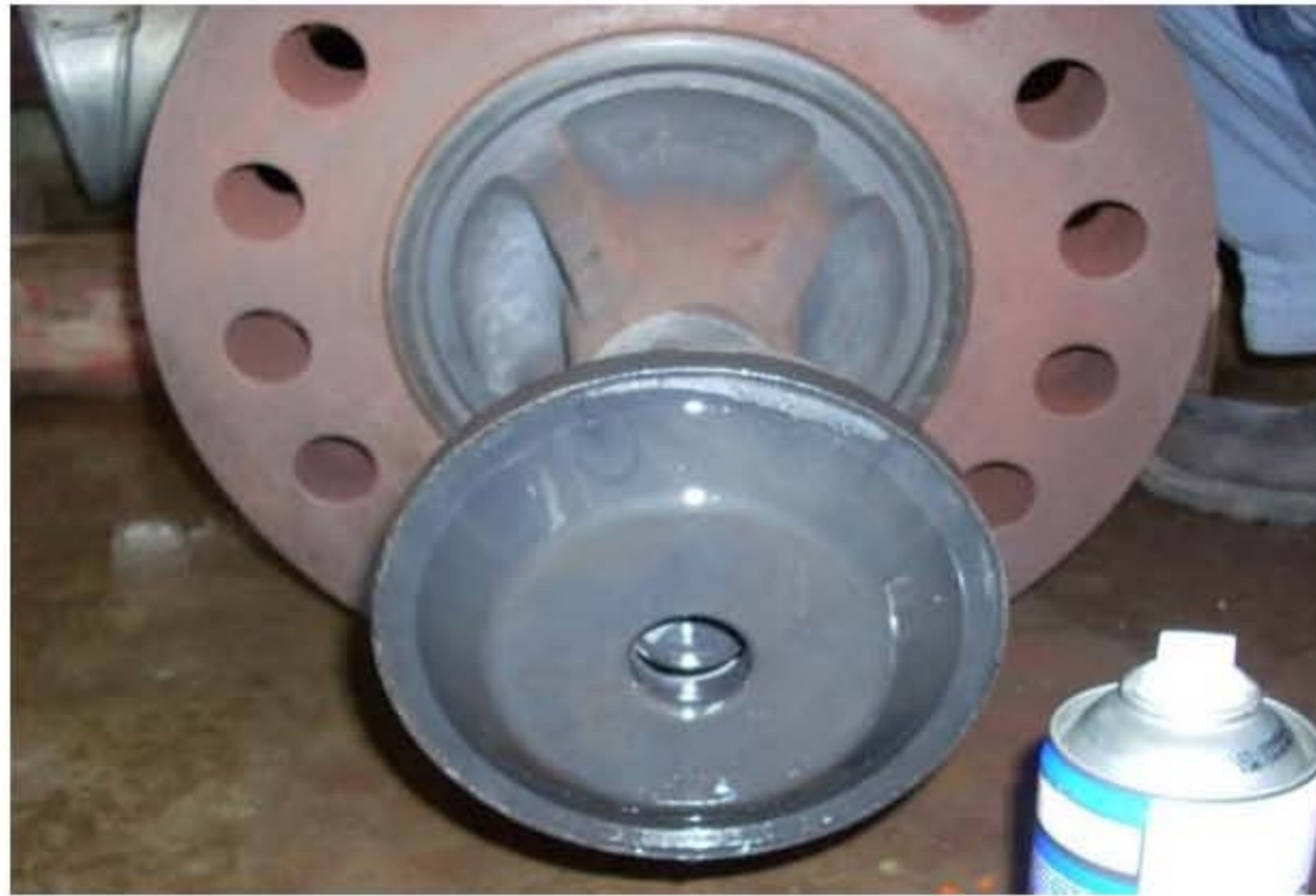
ภาพแสดง สภาพโดยทั่วไปของ VALVE CONE ของ STOP VALVE
