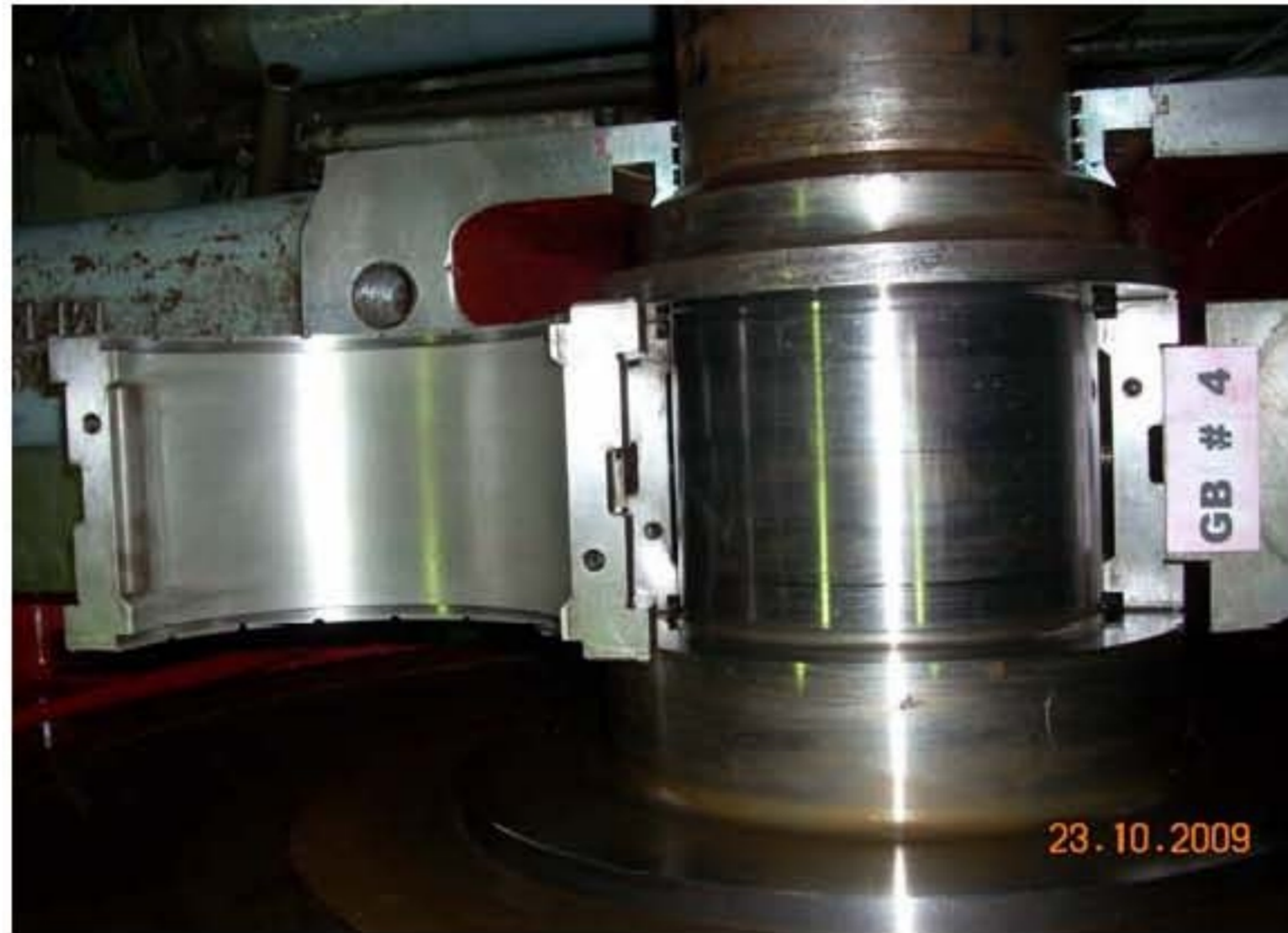
ภาพแสดง สภาพของ UPPER HALF ของ REDUCTION GEAR LOW SPEED SHAFT BEARING GENERATOR SIDE
