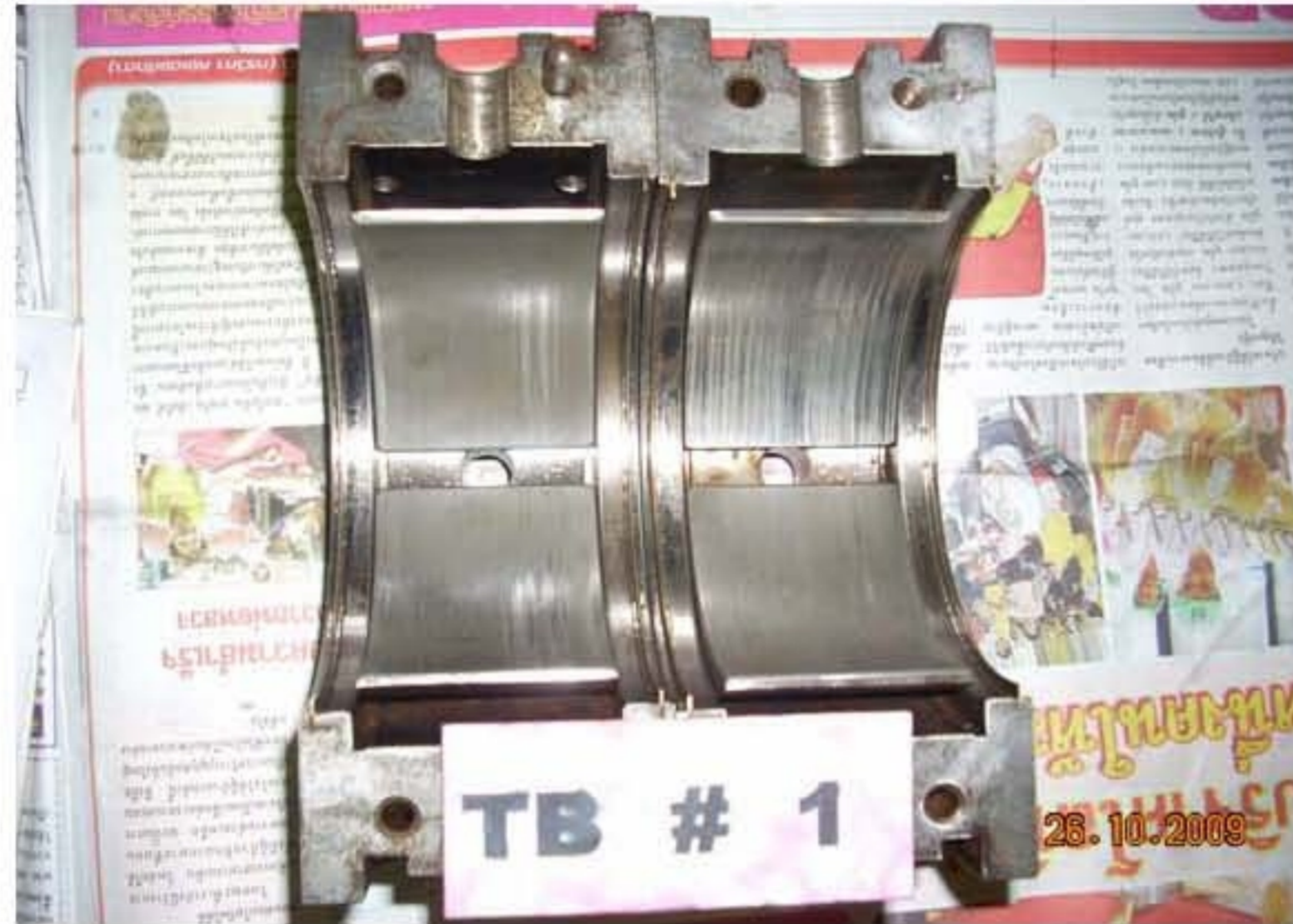
ภาพแสดง สภาพของ JOURNAL BEARING ของ STEAM TURBINE ด้าน STEAM END
