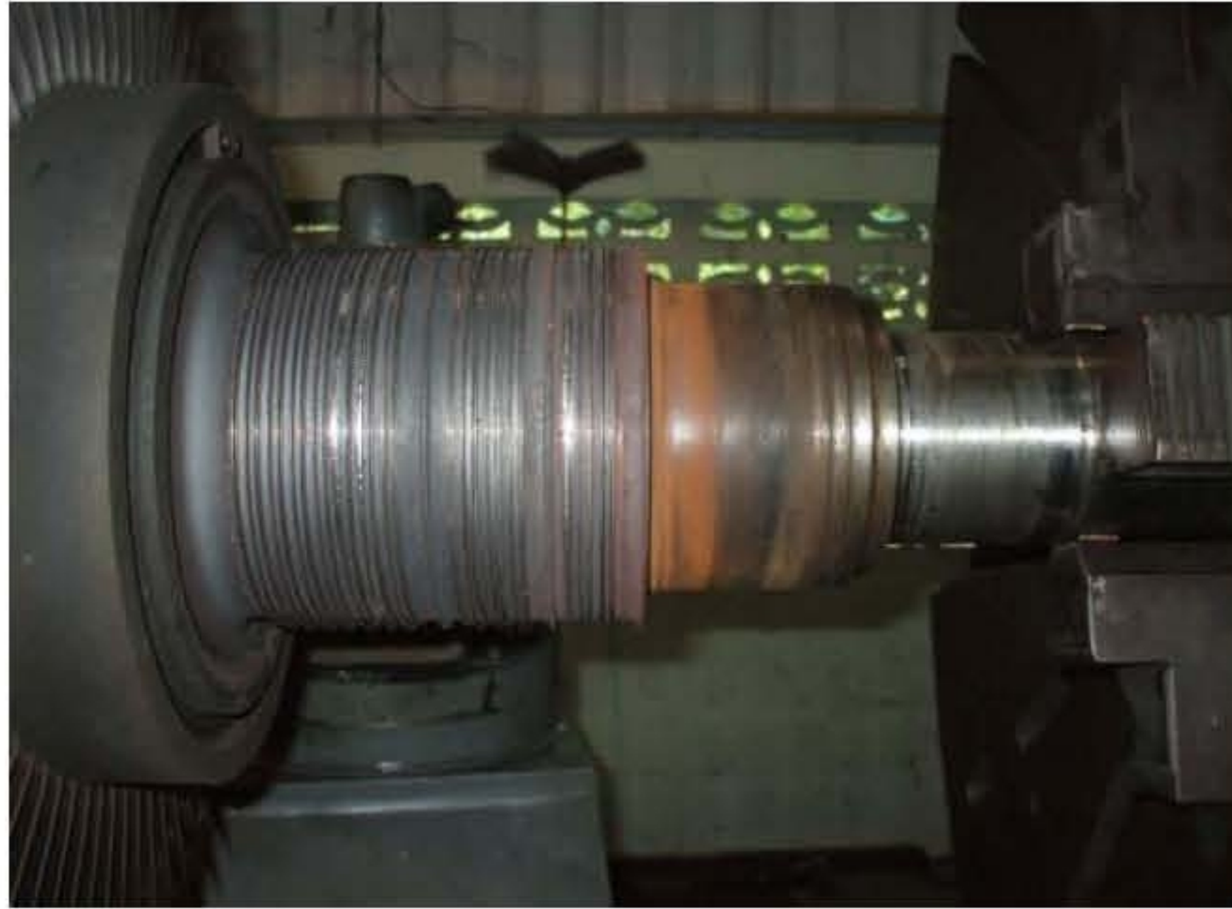
ภาพแสดง สภาพของ GRAND STEAM SEAL ด้าน EXHAUST END หลังจากทำการเปลี่ยน FIN 3 CYCLES
